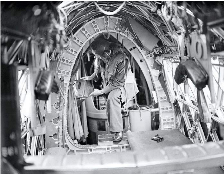
Blick durch den Rumpf zum Heckschützen: Die geodätische Struktur machte die Wellington leichter und stabiler als andere Weltkriegsbomber
