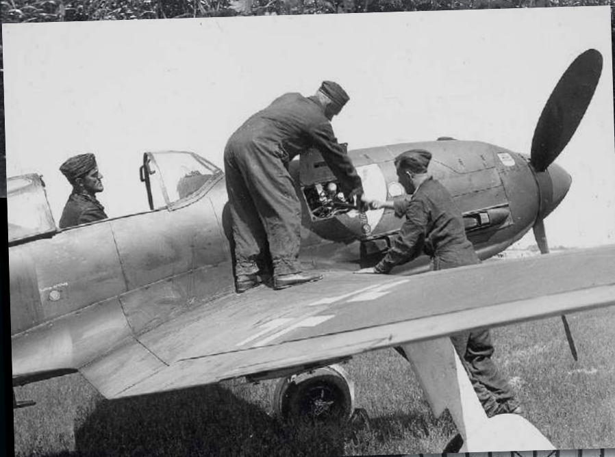
Zwei Mann beginnen mithilfe der Anlasskurbel, den Schwungkraft-Anlasser in Gang zu setzen
