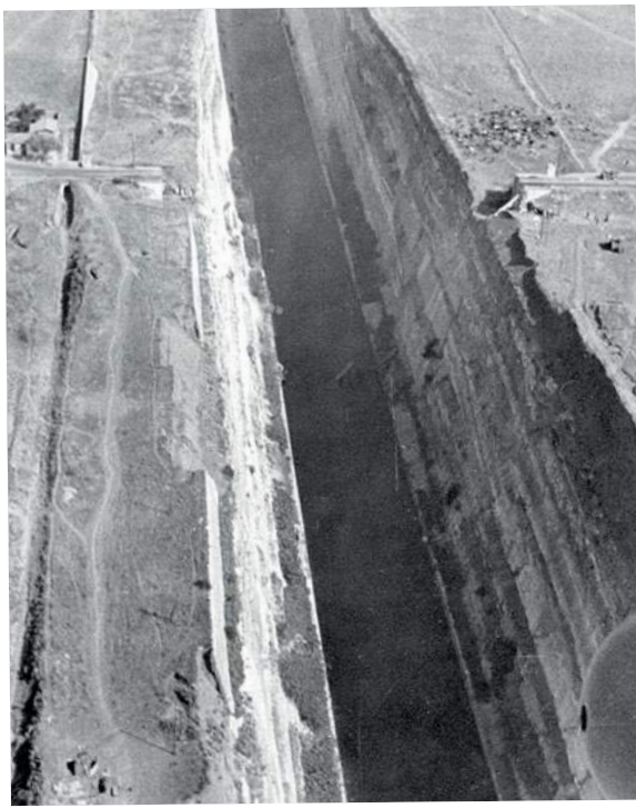
Zerstört: Als die Brücke schon eingenommen ist geht aus unbekanntem Gründen die vorbereitete britische Sprengladung hoch – das obige Foto zeigt das Ergebnis
