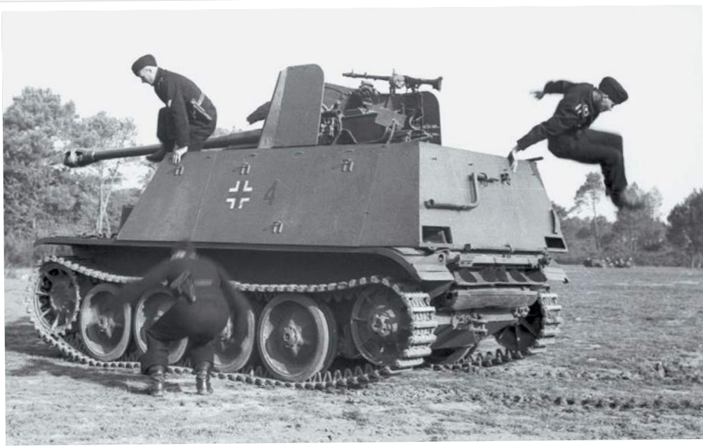
Abgesehen: Hier übt die Besatzung eines Panzerjägers „Marder II“, für den der „Schnellkampfwagen“ (Panzer II Ausf. D/E) das Fahrgestell liefert. Die offizielle Bezeichnung lautet „Panzerselbstfahrlafette I für 7,62-cm-Pak 36 (r) (Sd.Kfz. 132)
