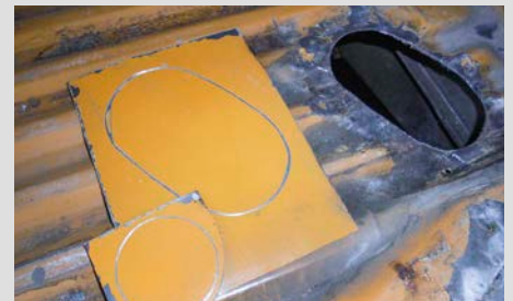
Passend zurechtgeschnittene Bleche verschließen das Loch fürs Abwasserrohr
