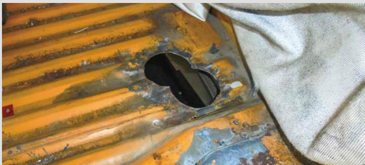
Das Loch im Bodenblech wird nicht mehr benötigt
