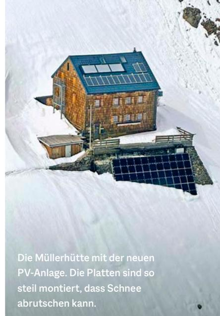
Die Müllerhütte mit der neuen PV-Anlage. Die Platten sind so steil montiert, dass Schnee abrutschen kann.
