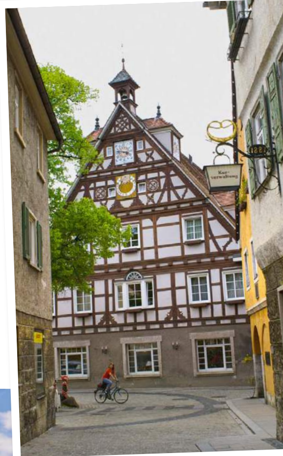
Die Schmuckfachwerk-Fassade des mehr als 400 Jahre alten Bad-Hotels im Zentrum von Bad Überkingen.
