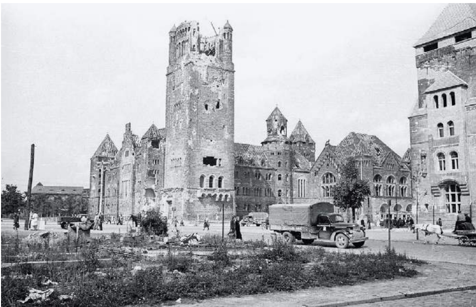
SCHWER BESCHÄDIGT: Das Posener Residenzschloss, ehemals Sitz des Reichsstatthalters und Gauleiters Greiser, im Jahr 1946. Weite Teile der Stadt werden während der Kämpfe 1945 zerstört
