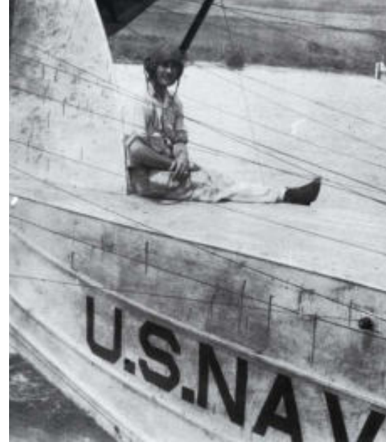
Zahllose Antennen waren zwischen dem Rumpf und dem Leitwerk verspannt
