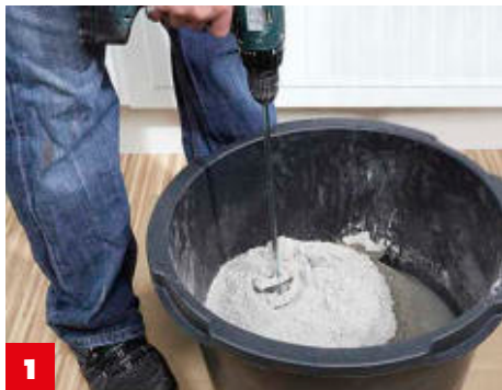
1 Erst Wasser, dann Pulver der Ausgleichsmasse in den 20-l-Eimer füllen. Anrühren , bis die Masse klumpenfrei und sämig ist.
