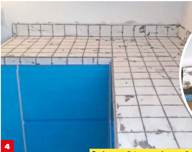
1 Fliesen auf die Höhe der Vorderkante zuschneiden , Fliesenkleber auftragen, mit Zahnkelle verteilen, Fliesen andrücken.
