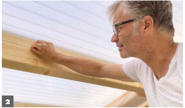
2 Insbesondere wenn Stoffe wie etwa ein Sonnensegel an den Querbalken entlang laufen, ist ein Verkleben der Seilbänder , an denen das Segel befestigt ist, ratsam.
