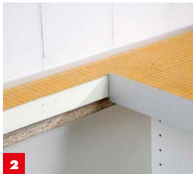
2 50-mm-Alu-Winkelleiste mit Montagekleber an die Kanten des Ausschnitts kleben, 48 Stunden fixieren.
