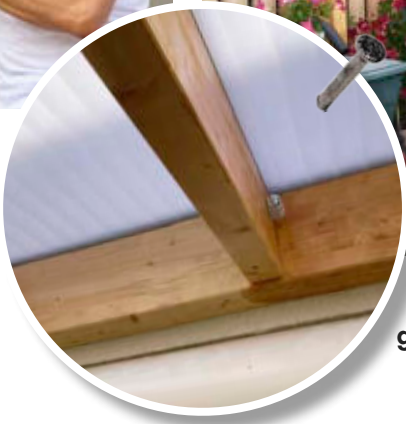
5 ... Lasur gründlich aus. Verwenden Sie bei den engeren Stellen an den Querhölzern den 25-mm-Pinsel. Die Lasur 4 bis 6 Stunden trocknen lassen und ein zweites Mal streichen.
