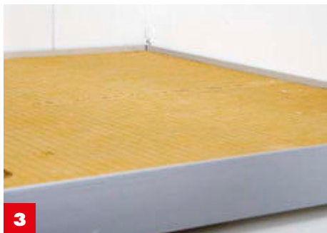
3 Winkelleiste rundherum nach oben hin abkleben, damit Ausgleichsmasse und Wand nicht in Kontakt kommen können .
