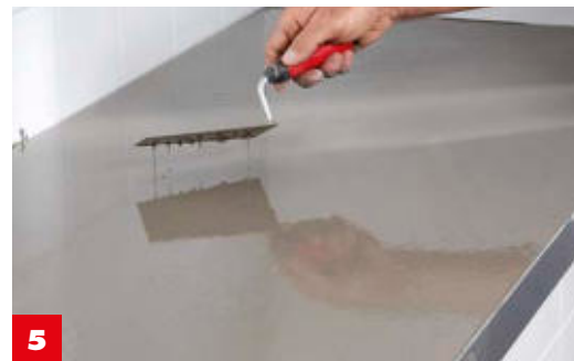
5 Mit der Kelle können Sie den Verlauf der Masse unterstützen und bis zu den Kanten ziehen . Ein bis zwei Tage abbinden lassen.
