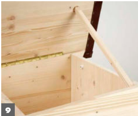
9 ... Leiste per Forstnerbohrer ein 6-mm-Sackloch in die Dachplatte bohren. Seitlichen Zwischenbodenhalter montieren.
