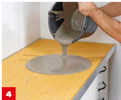
4 Masse in kleinen Portionen in Mitte der Platte gießen . Darauf achten, dass sie nicht über die Kanten läuft.
