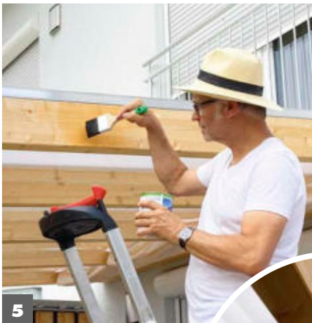
5 ... Lasur gründlich aus. Verwenden Sie bei den engeren Stellen an den Querhölzern den 25-mm-Pinsel. Die Lasur 4 bis 6 Stunden trocknen lassen und ein zweites Mal streichen.
