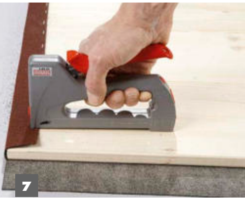
7 Mit Handtacker und entsprechend langen Klammern befestigen Sie nun die Dachpappe auf der Dachplatte.
