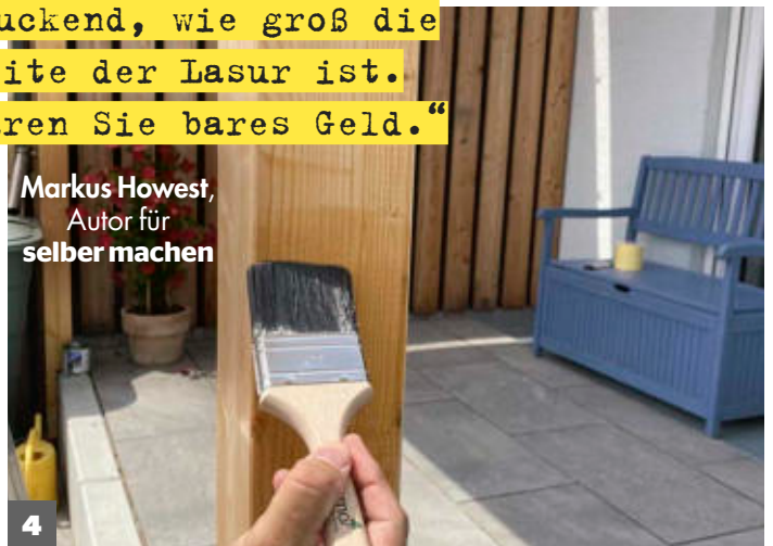
4 Tragen Sie nun die Lasur dünn mit einem Flächenstreicher auf . Für die Pfosten eignet sich der 50 mm breite Pinsel. Immer in Holzmaserrichtung auftragen. Danach streichen Sie die ...
