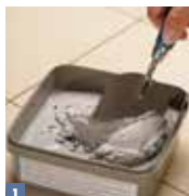
Für das sorgfältige Durchmischen der gebrauchsfertigen Fugenmasse reicht eine kleine Kelle völlig aus.
