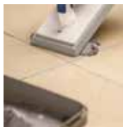
Mit einem Fuggummi lässt sich die geschmeidige Masse nun ganz leicht oberflächenbündig in die Fugen eindrücken.
