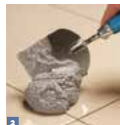
Setzen Sie drei bis vier Mörtelbatzen auf etwa einen Quadratmeter Fliesenfläche. Die Randfugen bleiben frei.
