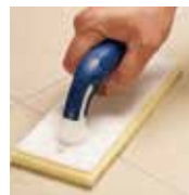
Beginnen Sie mit dem Glätten der Fugen, bevor die Masse ansetzt. Das Schwamm Brett feucht, aber nicht nass halten.
