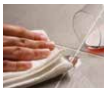
Mit einem Fuggummi lässt sich die geschmeidige Masse nun ganz leicht oberflächenbündig in die Fugen eindrücken.
